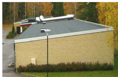
Figur 8. Pulpettak täckt med papp på skolbyggnaden.
