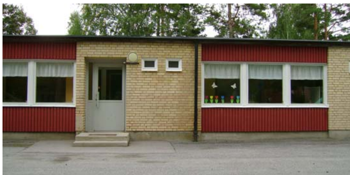
Figur 6. Tegel- och träfasad på skolbyggnaden.
