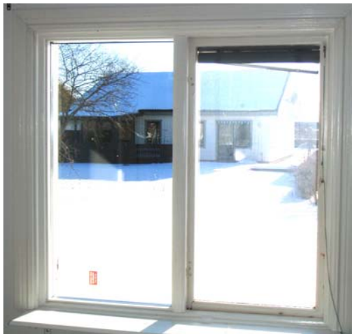
Figur 13. Det vänstra fönstret är omgjort till ett fast fönster. Det högra är ännu oförändrat. Karmen behålls men bågen kasseras och en kassett med tre isolerglas monterats.
