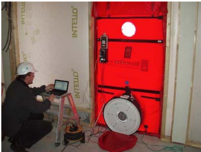
Figur 5.5.1 Täthetsprovning av byggnad. Källa http://www.byggmiljogruppen.se/tjanst_lufttahetsprovning.html , (2010-05-05)
